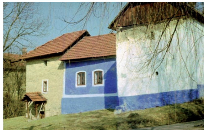
Fig. 2 - Ferme en brique crue de la région de Luhačovičské Zálesí, Kaňovice, distr. Zlín (Zuzana Syrová)
